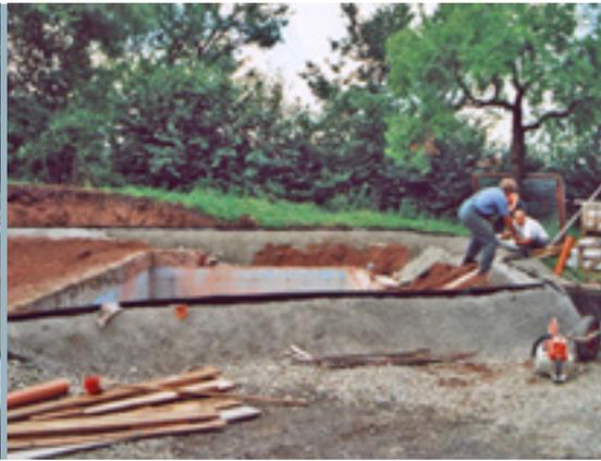
Alte Swimmingpools bieten gute Voraussetzungen zum Umbau in einen Schwimmteich. Damit aus dem Swimmingpool ein Schwimmteich wird, müssen die Beckenwände verändert und eine Aufbereitungszone installiert werden.
