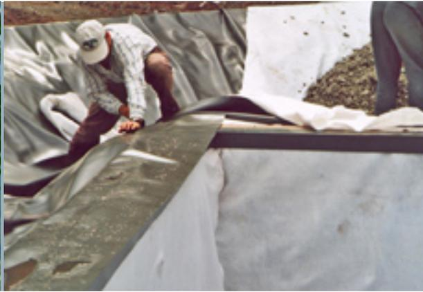
Bei der Wallbauweise sorgt der standfeste Untergrund für die Trennung der beiden Zonen.
